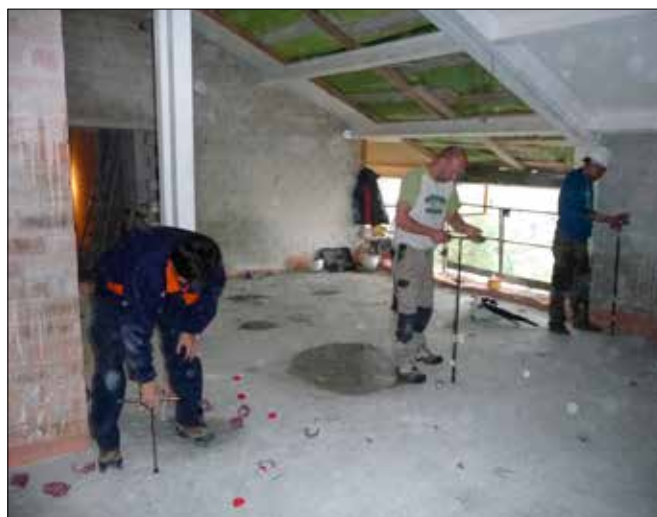
Instalación soporte FZH+Sylomer®.
