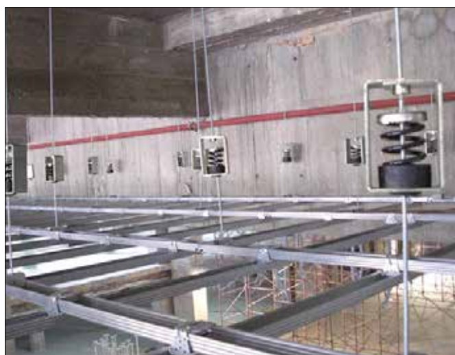
Instalación de soportes VT.
