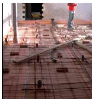
Colocacion del mallazo y hormigonado.
