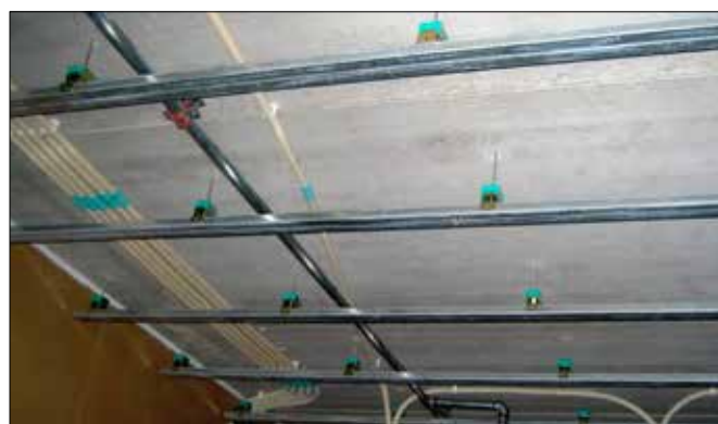
Aplicación del Acústico SUPER T60+Sylomer 30 tipo B
